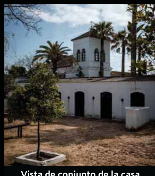
Vista de conjunto de la casa patronal con los establos delante. Yeguada MF de la Escalera.
